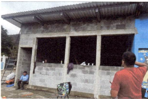
Foto 3: medicion de purta y ventanas de pvc
