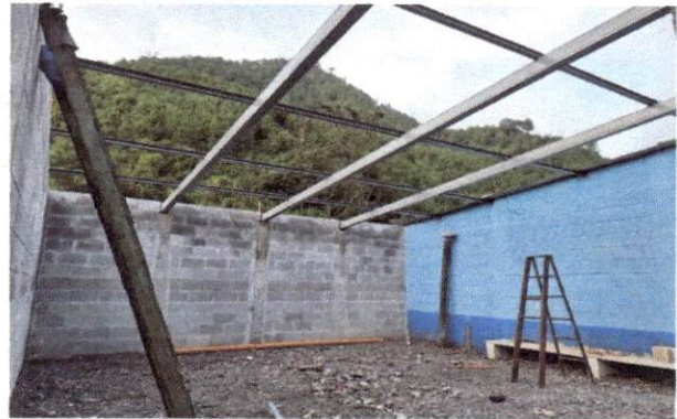
Foto 2: colocacion de estructura metalica y techado troquelado
