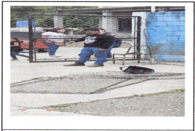
Foto 3: colocacion de malla
